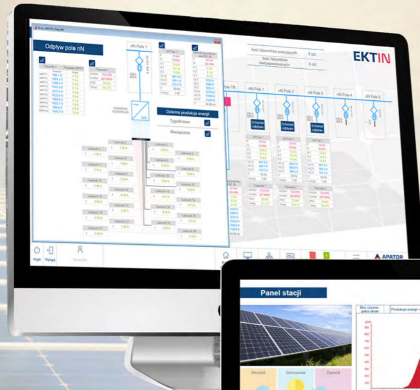
Widok panelu dyspozytora - poziom falowników/stringów
